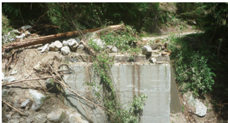
木曾森林管理署南木曾支署 南蘭（大迷沢）林道
