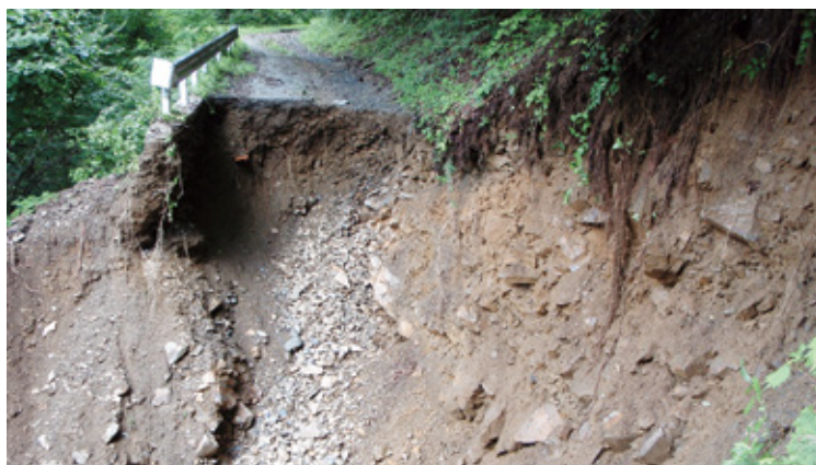
中信森林管理署 贛川橋戸（贛川）林道
