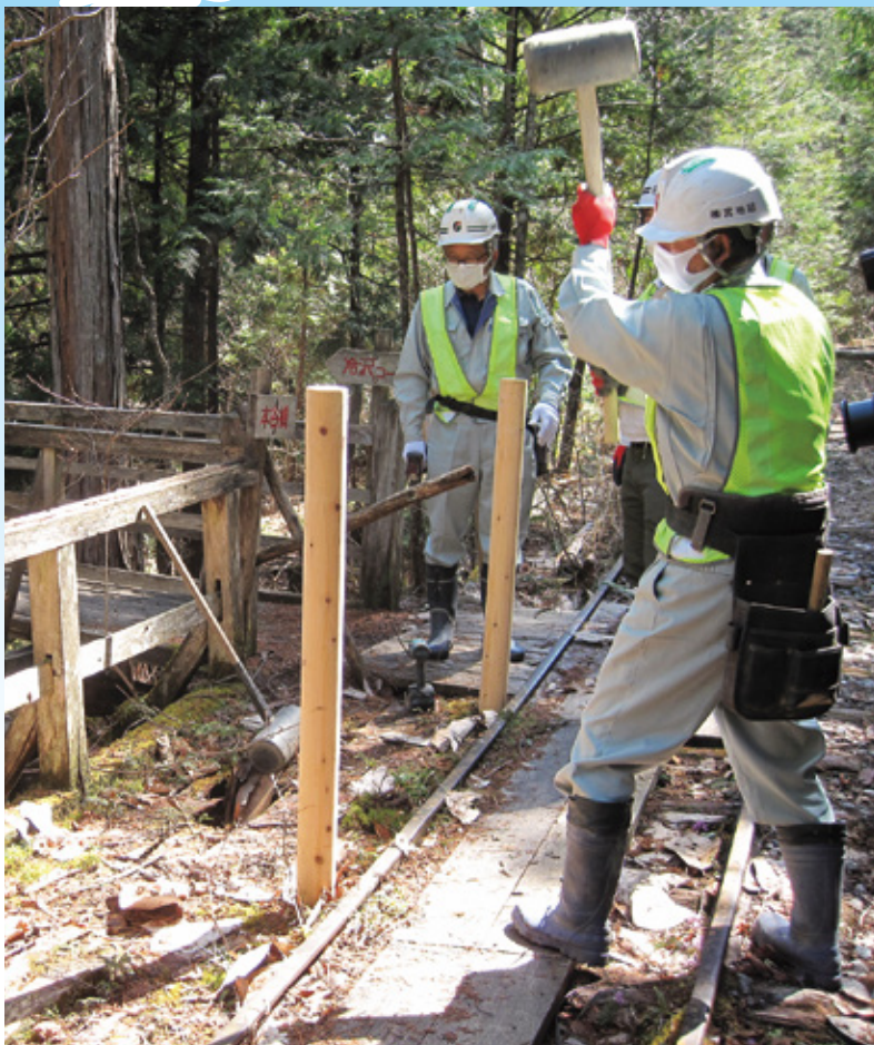
杭打ち作業の様子
