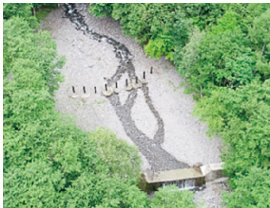
流木対策の実施（流木捕捉工）（中信署）
