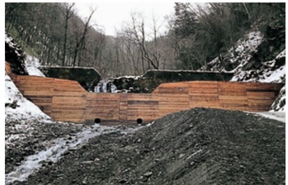
長野県知事賞 中信森林管理署 谷止工（平割材残存型枠工）
