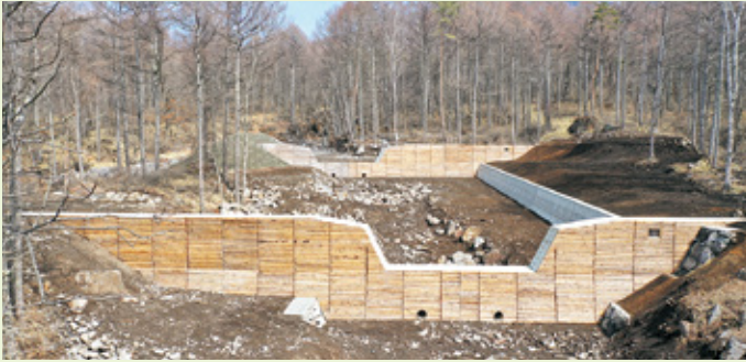
キッカケ沢復旧治山工事（施工者 スワテック建設株式会社）
