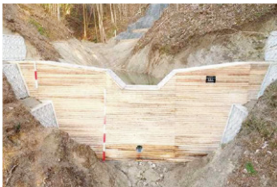
白井沢（フカ洞）復旧治山工事 施工者 有限会社共和土木
