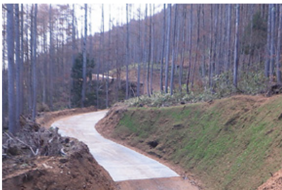
大持林業専用道新設工事 施工者 マツナガ建設株式会社
