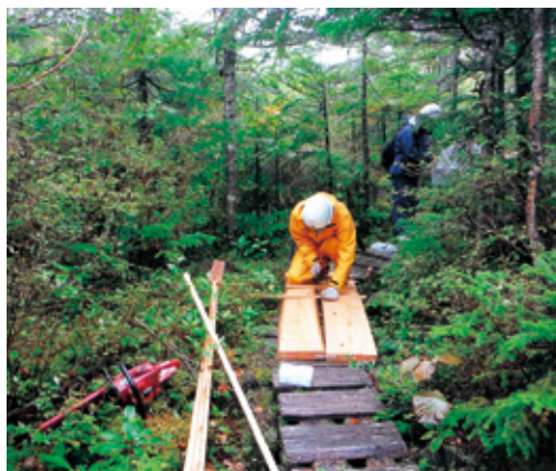
腐食した木道の補修作業の様子
