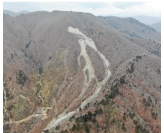
滝波谷の山腹崩壊
