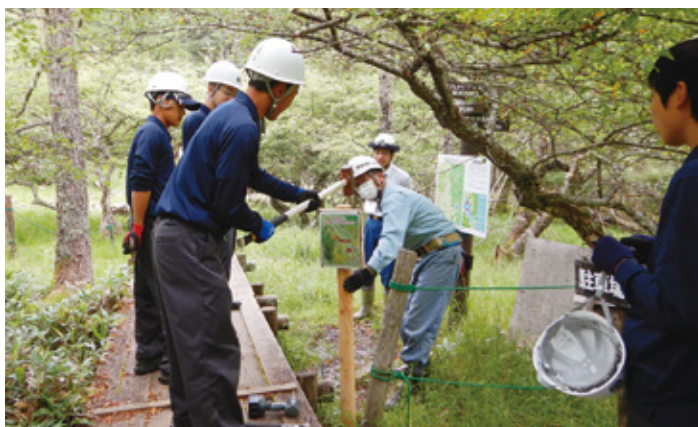
遊歩道の看板の設置を行っている様子
