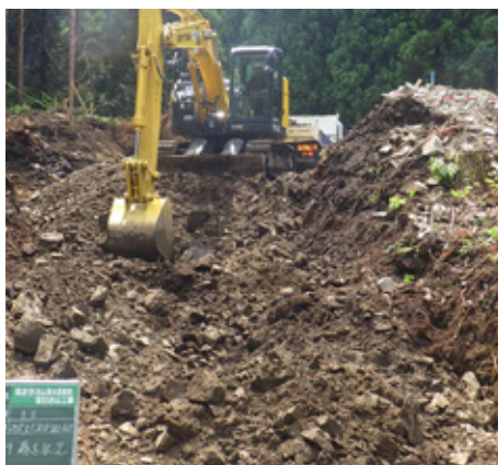
切土作業の様子
