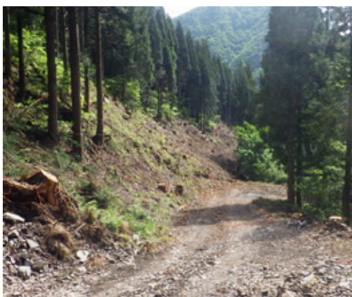
伐採の終わった現場の様子
