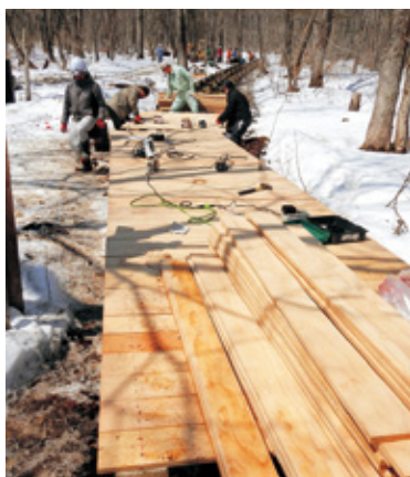
木製遊歩道改修中の様子
