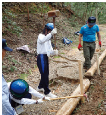
中学生に歩道修繕方法を 指導している様子
