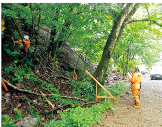
治山工事の支障木調査を行っている筆者
