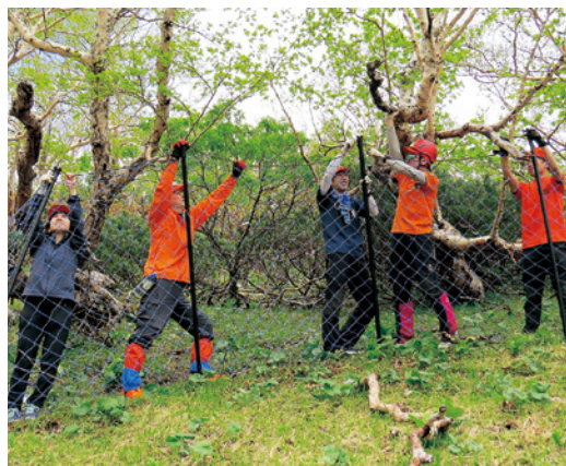
防鹿柵を設置している様子
