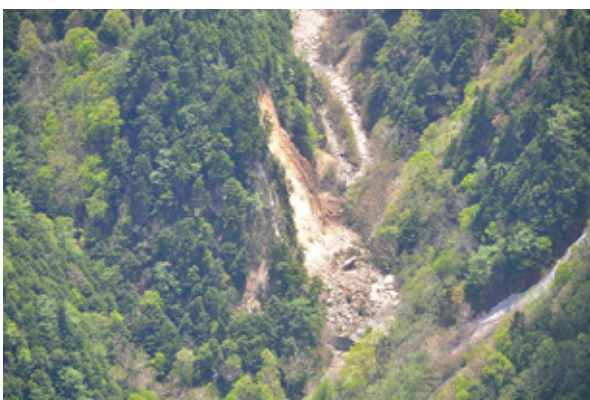
令和 2 年 5 月 30 日撮影：松本市上高地国有林（六百沢）治山ダムが崩落土砂を捕捉
