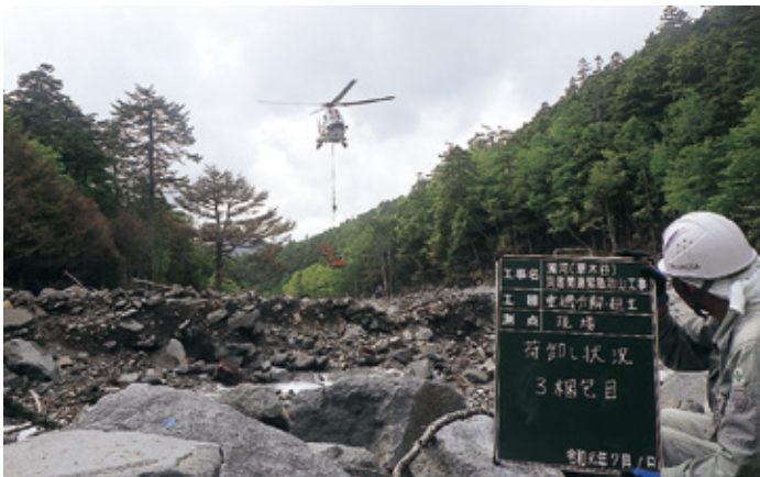
分解した重機をヘリコプターで搬入する様子
