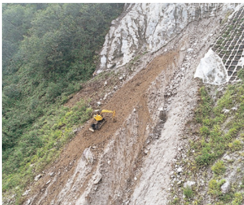
ロッククライミングマシンの施工状況
