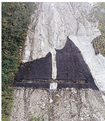
完成した工事
