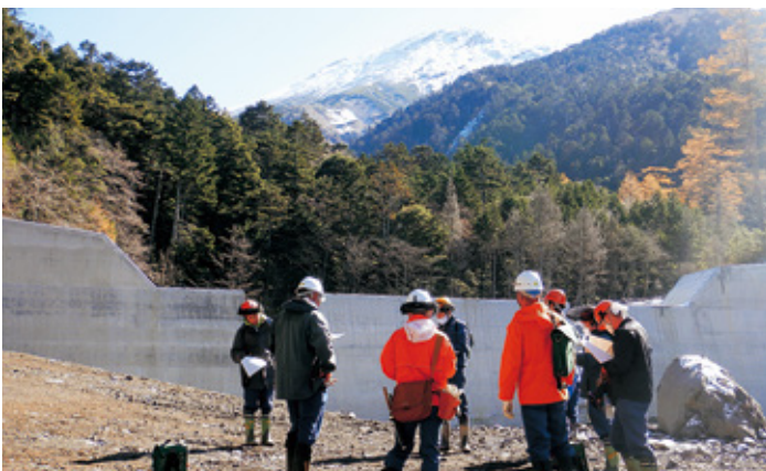
コンクリートスリットダム工の施工地で現地検討の様子
