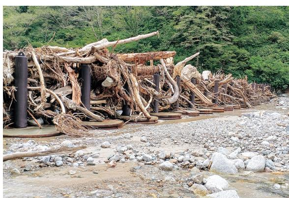
「流木捕捉工」により捕捉した流木
