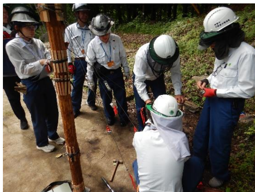
架線集材研修 設置を行うことで集材架線の仕組みを理解する
