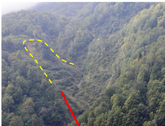
山腹工の施工により緑化が図られた 土石流発生源崩壊地①
