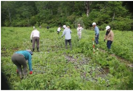
ワイヤーメッシュ敷設作業の様子
