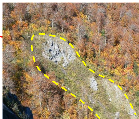
山腹工の施工により緑化が図られた土石流発生源崩壊地②
