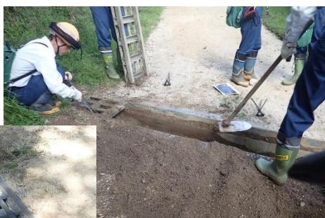
(写真上) ベテラン職員の指導を受け、横断溝の重いフタを外して土砂を除去する
