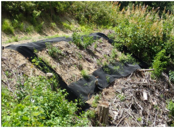
南信署の特殊樹脂ネット設置箇所
