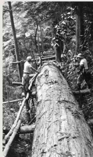
①丸太を滑らす簡易な道「サデ」に載せられた用
