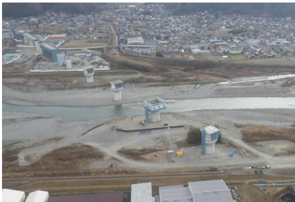
天竜川で橋脚工事が進むリニア中央新幹線 (伊那谷総合治山事業所上空から撮影)
