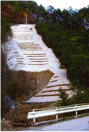
崩壊地の山腹工完成 (平成 20 年)
