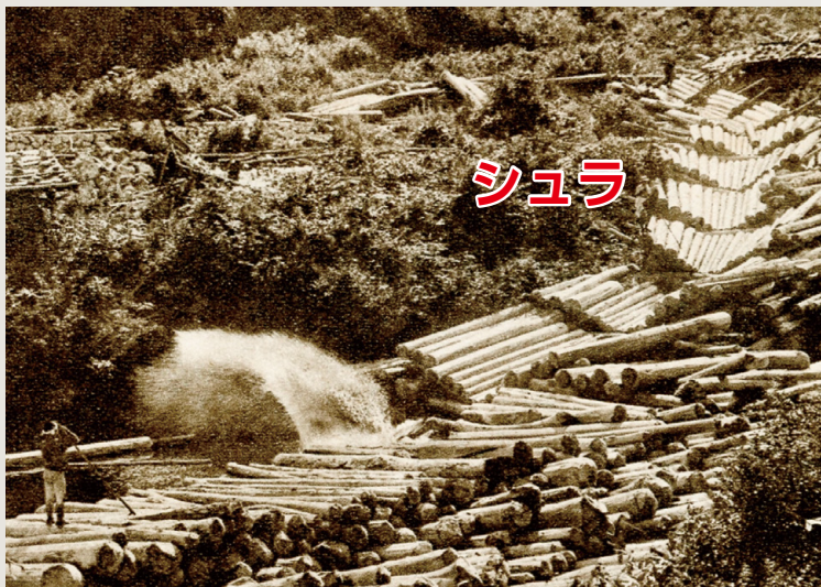
大正時代頃、川の上流部での小谷狩の風景(飛騨)丸太を並べた滑り台的な装置「シュラ」が多用され、「山落とし」と見た目は非常に似ている
