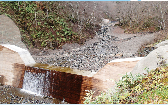
木製型枠を利用した治山ダム（溪間工）
