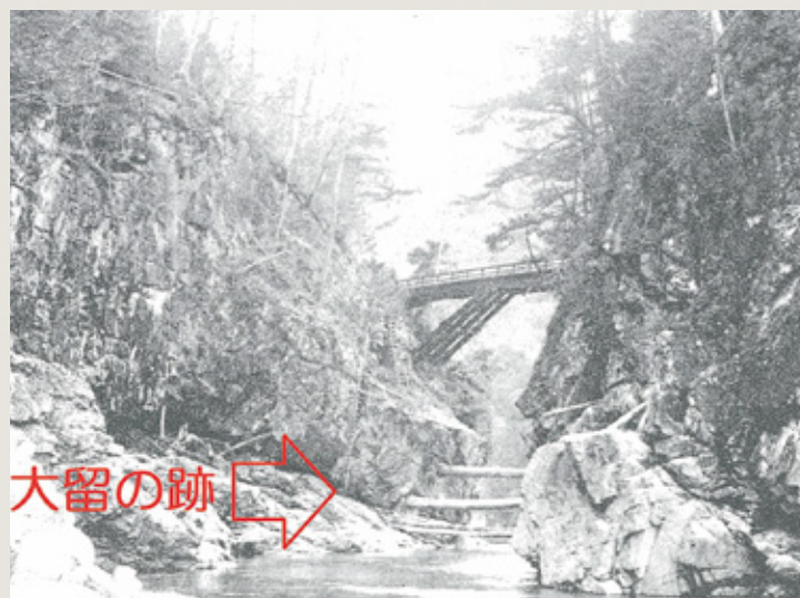
昭和初期の絵葉書より、当時まだ木曾に残っていたとされる「大留」の跡(現在の木曾森林管理署王滝国有林水ヶ瀬)「根太」と思われる太い丸太が見られる
