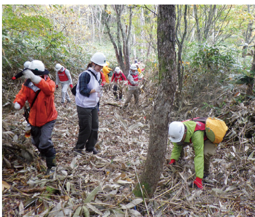
新しく開設する歩道の整備
