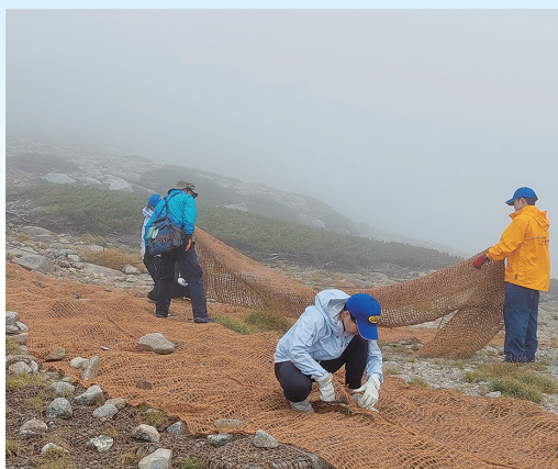
霧中での植生マット敷設作業
