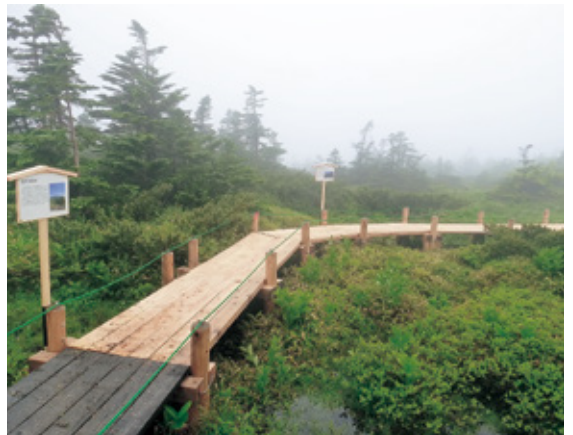
補修された遊歩道
