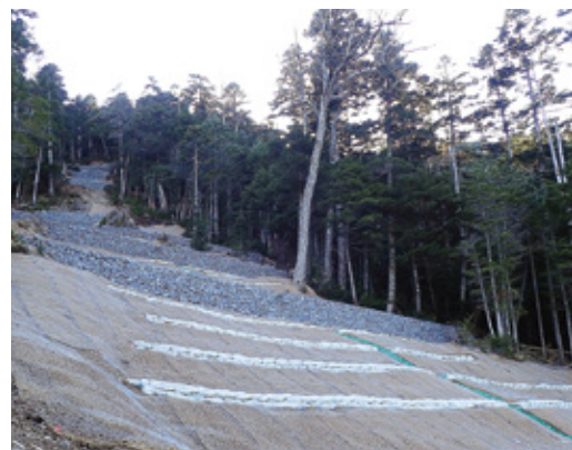
雪深く、一年のうち7ヶ月しか作業できません。雨も多く濁水処理には気を使いました。
