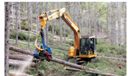
現場作業の様子
