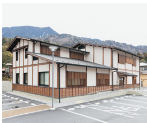
南木曽支署新庁舎
