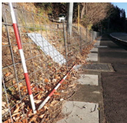
設置した野生イノシシ移動防止柵 (古城山沿い)
