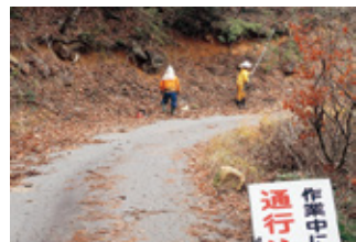
トラック運材等に支障になる灌木の除去
