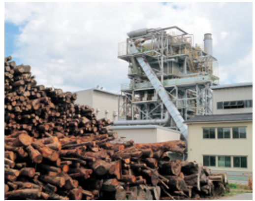
瑞穂バイオマスパワー (木質バイオマス発電施設)
