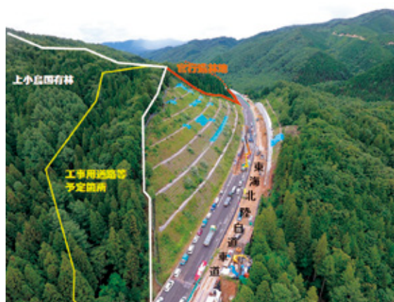
現地の状況(写真提供:中日本高速)
