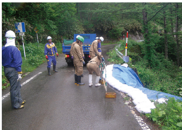
点検により発見された路肩を簡易保護
