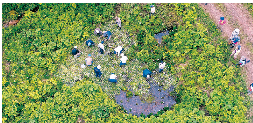
ワイヤーメッシュを設置（ドローンにて撮影）
