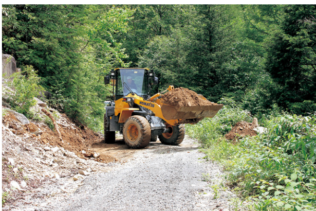
代替路確保のため崩土除去（請負者：みどり産業株式会社）
