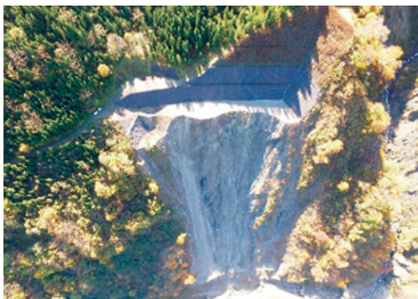
蒲原沢復旧治山工事箇所
