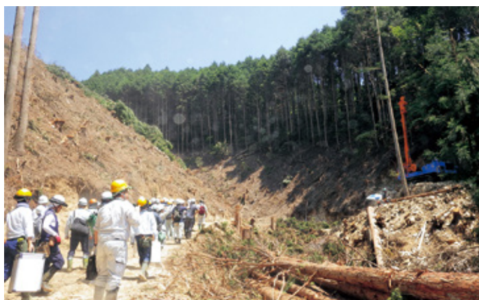
タワーヤードによる全木集材作業を見学
