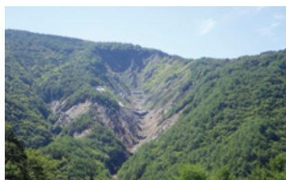
復旧工事を進めている鶯ヶ巣治山工事箇所(全景)
