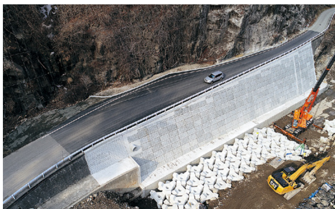
完成した林道
