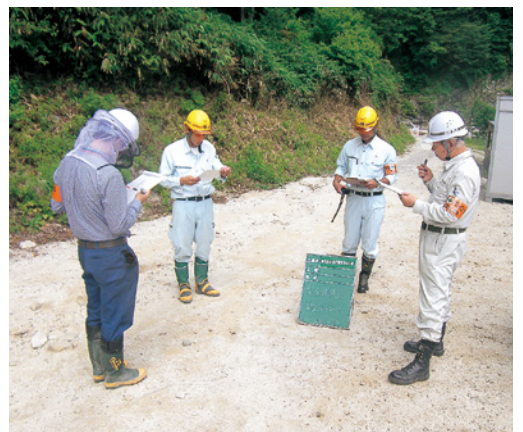
安全パトロールの様子
