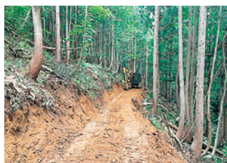
完成した森林作業道
