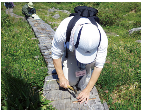
特殊な板の打ち付け作業中
