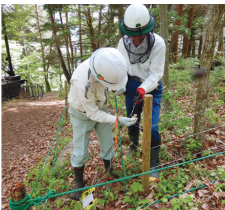
電気柵を取り付け中
