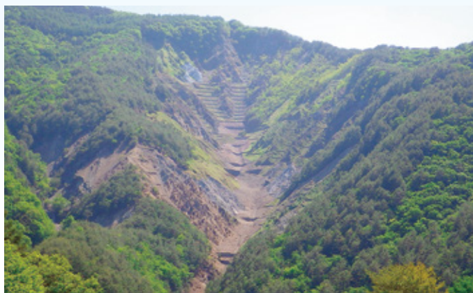
復旧が進む鷲ヶ巣大崩壊地（直轄治山事業）
