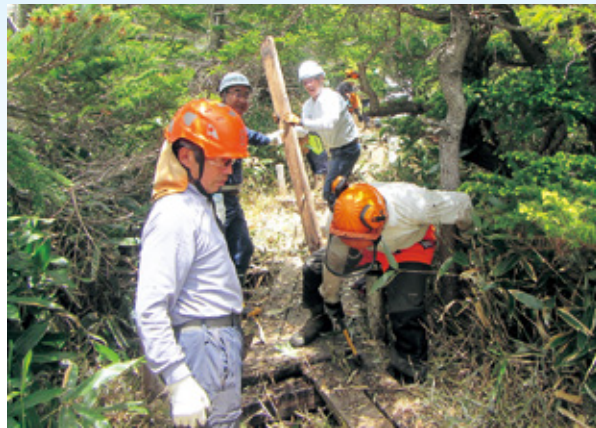
歩道の板材を撤去する参加者
