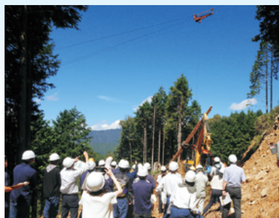
架線集材の様子を見学する参加者
