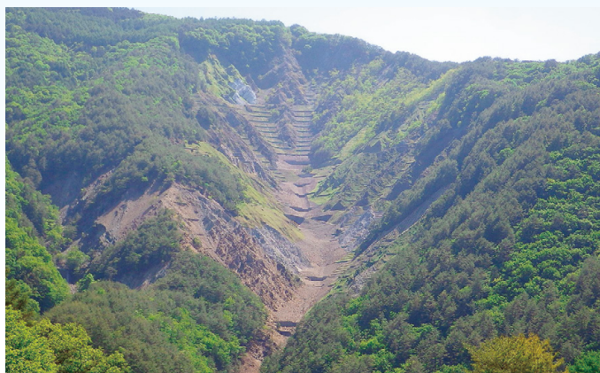
復旧が進む鳶ヶ巣大崩壊地（直轄治山事業）
