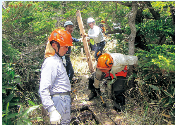
歩道の板材を撤去する参加者
