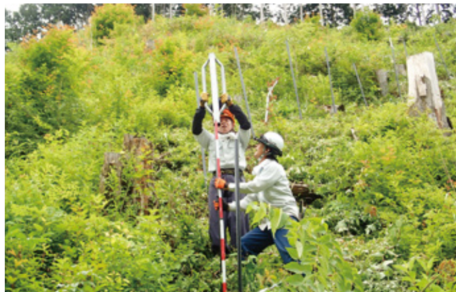
獣害防護柵を修理する職員
