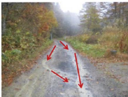
路盤を流れた水は排水溝で排水
