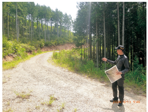
作設済みの屋根型作業道の現状を説明
