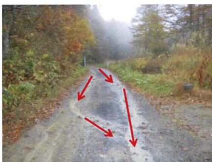
路盤を流れた水は排水溝で排水
