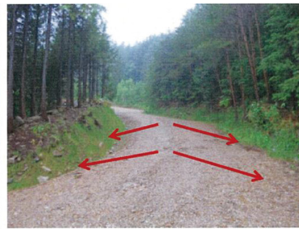
屋根型構造で両側に排水
