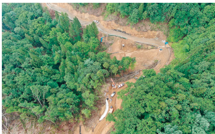
本現場で、これまでに整備した林道
