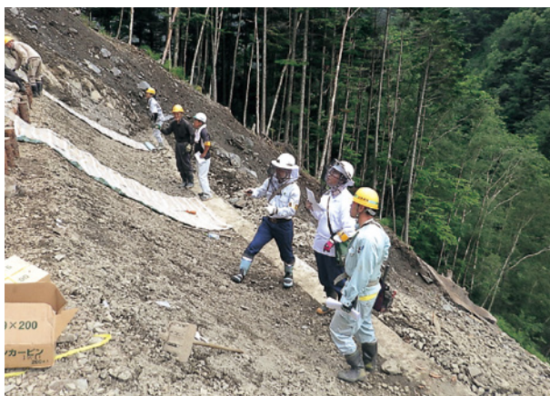
上伊那地区の山腹工の点検状況
