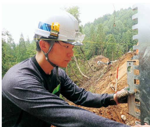
擁壁材据え付け中の筆者
