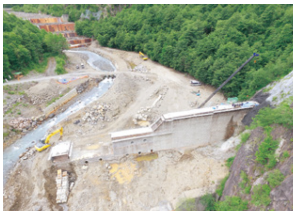
濁川（第65号）現場の様子
