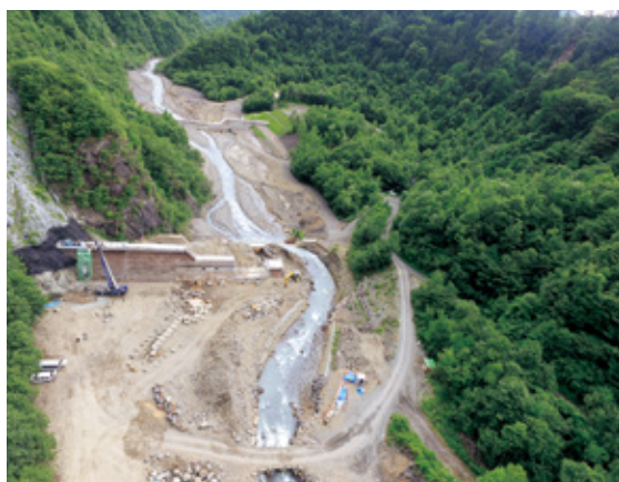
濁川（第65号）現場の様子
