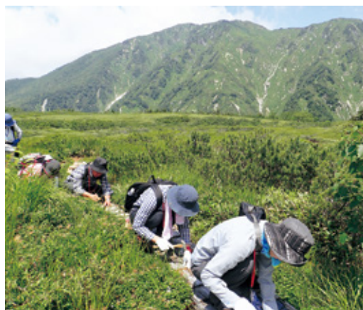
木道にスリップ防止板を設置する様子
