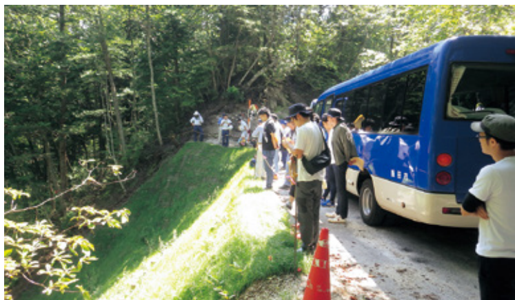
治山技術官による工事の現地説明
