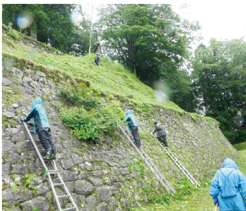
城壁の草刈り作業の様子
