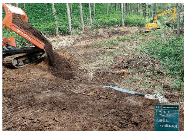
林業専用道新設工事の様子
