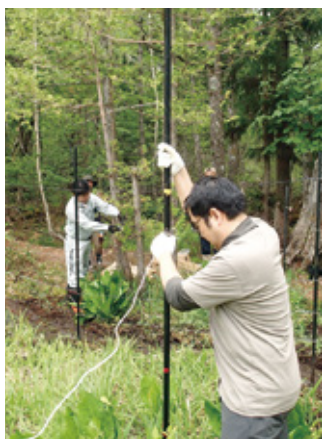
電気柵の設置作業
