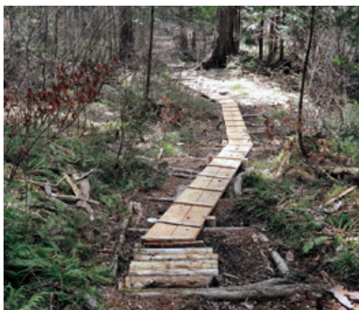
整備が完了した遊歩道
