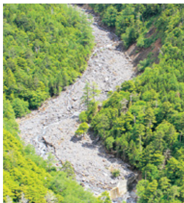
土石流により既設の治山ダムに異常堆積した状況
