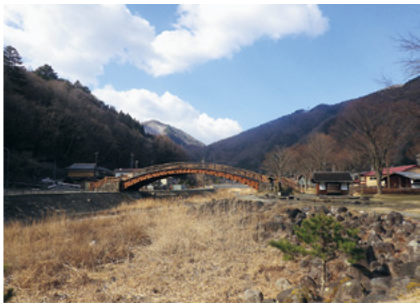
事務所から見える木曾大橋
