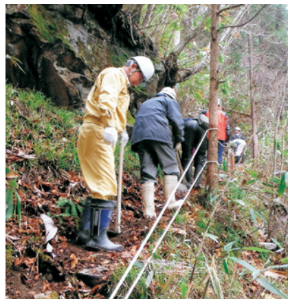
急峻地にロープを張り歩道面を整備
