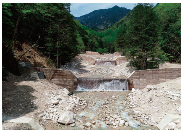
完成した谷止工工事現場の様子
