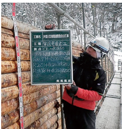
谷止工コンクリート出来形検測の様子
