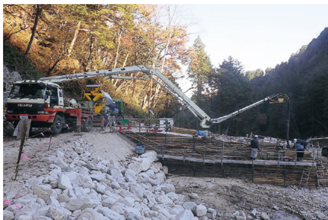
生コンクリートを流し込んでいる様子
