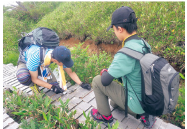
滑止板の設置作業
