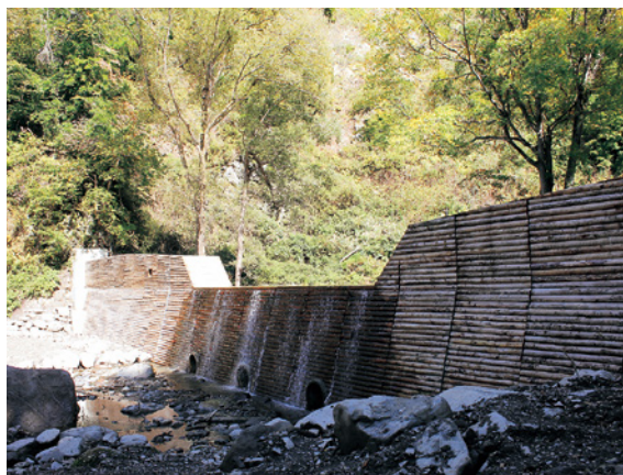
北信署の丸太残存型枠工（長野県飯山市）
