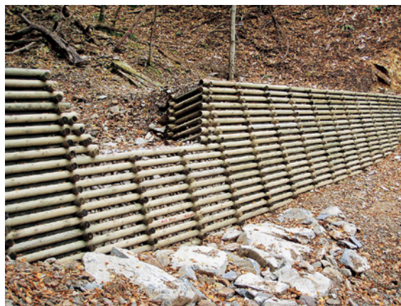
東信署の木製校倉式土留工（長野県上田市）
