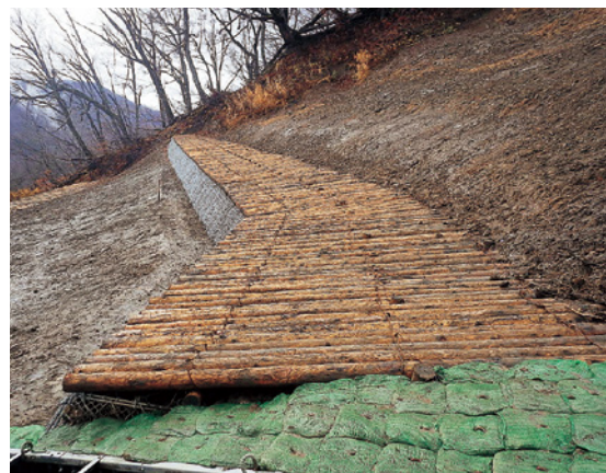
中信署の木製天端保護工（長野県小谷村）
