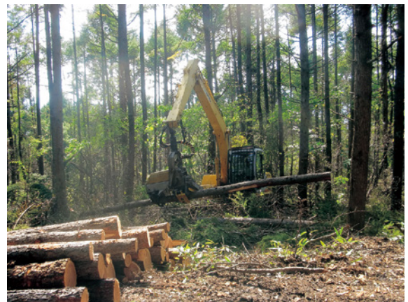
高性能林業機械（ハーベスター）で伐採の様子
