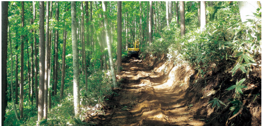
市場化テスト事業地（作業道開設）
