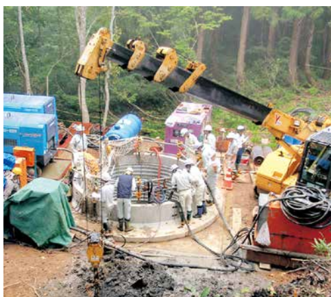
地すべり防止工事の集水井の見学
