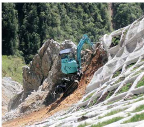
ロッククライミングマシンによる法面整形
