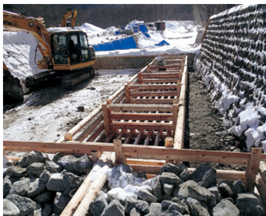
玄文沢【上高地】工事実行状況（1月中旬）
