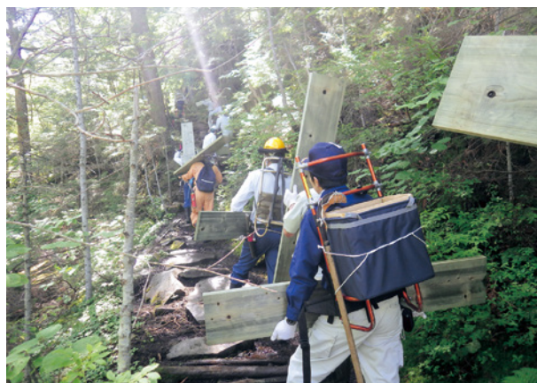
人力による材料の運び上げ
