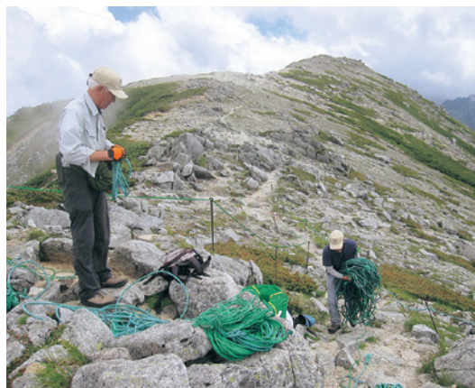
GSSによるグリーンロープ張り替作業
