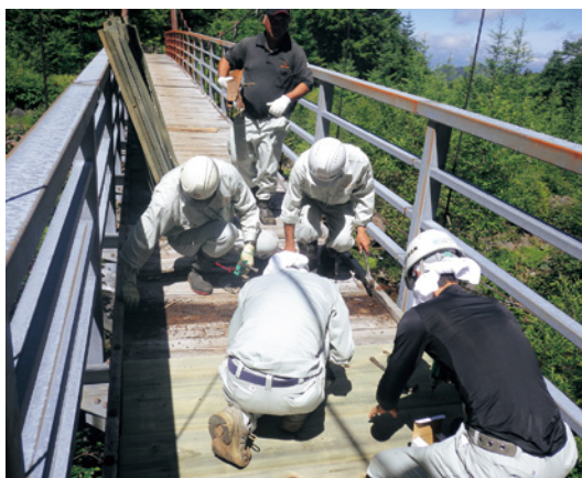
仙人橋の床板張替作業
