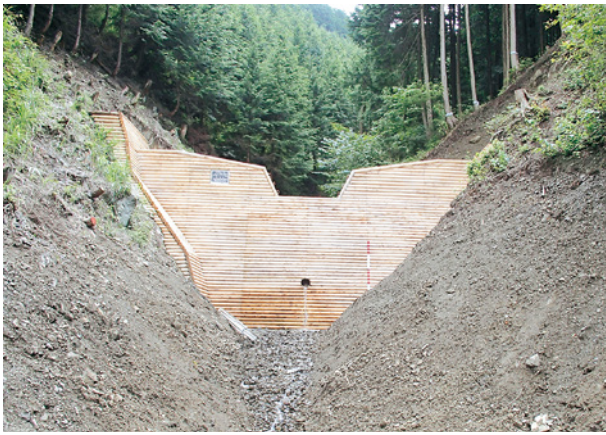
榑原谷国有林の谷止工
