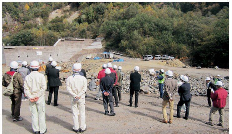
施工中の土石流対策工（谷止工）を説明
