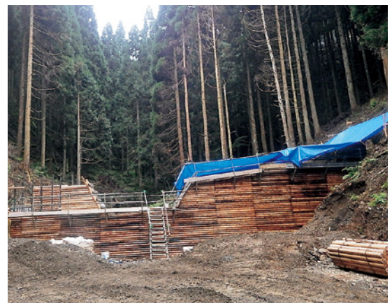
施工中の足打谷国有林の谷止工
